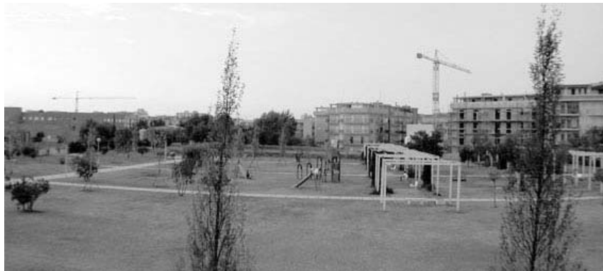
Lavori in corso per la villa comunale di Corato
