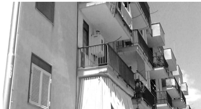
Una delle caldaie della palazzine Iacp di via Corsica
